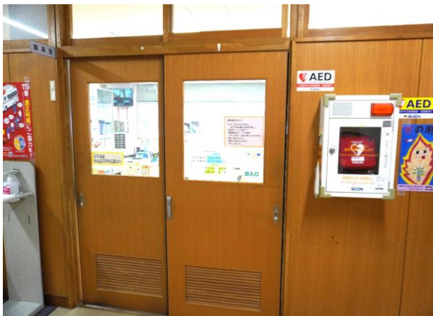
【津幡中学校】 2階職員室前
