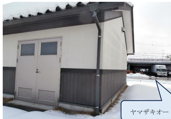
倉庫外観（入口）2
