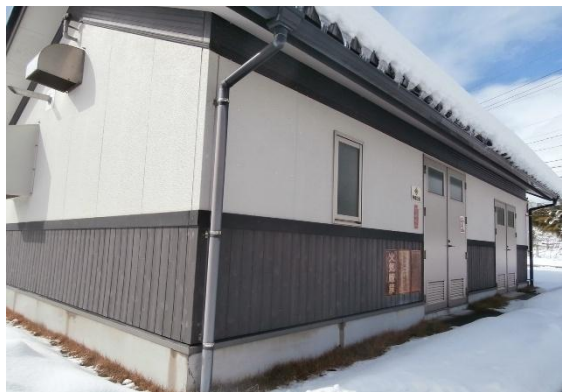
倉庫外観（入口）1
