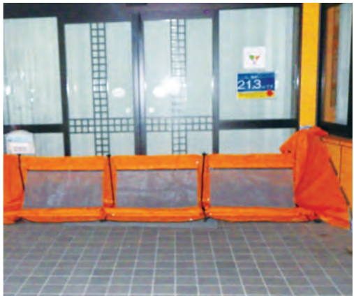
止水板を設置した刈安公民館
