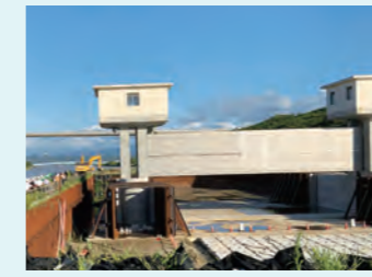
建設中の河北潟放水路防潮水門
