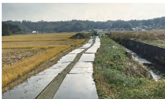
地盤の緩い土壌に対応
