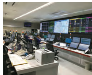
通信指令センター
