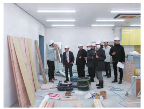
商店街旧店舗を学童保育施設に改装 (津幡小学校区)
