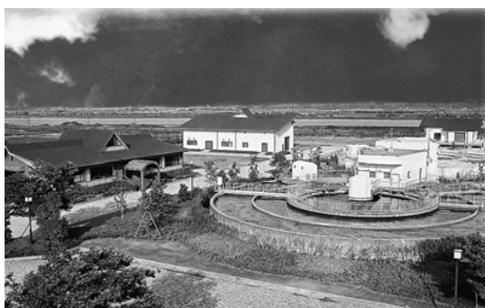
町浄化センター
