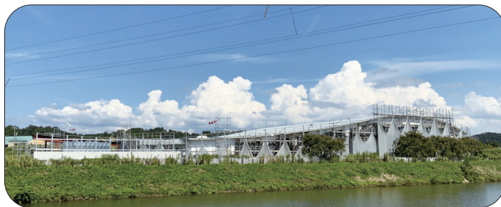
▶ 工事が進むアザレア
