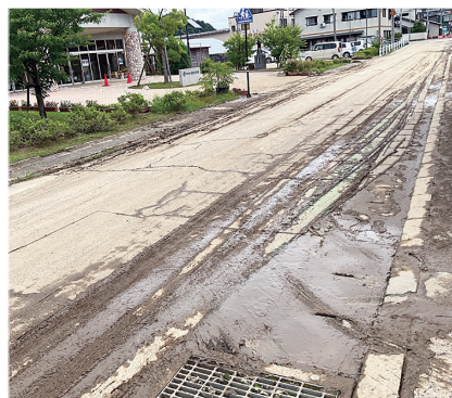
泥だらけになった津幡小学校前
