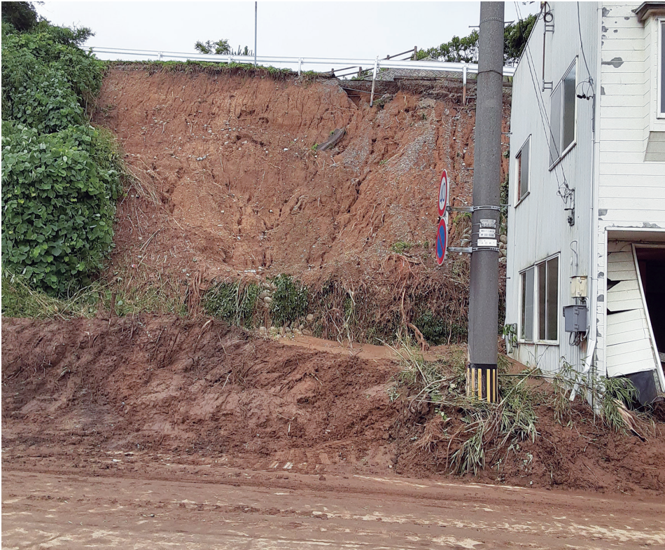
▲建物を巻き込むがけ崩れ（鷹の松南墓地公園下）
