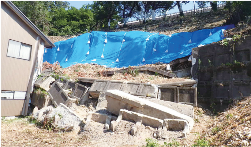
▲民家を巻き込むがけ崩れ
