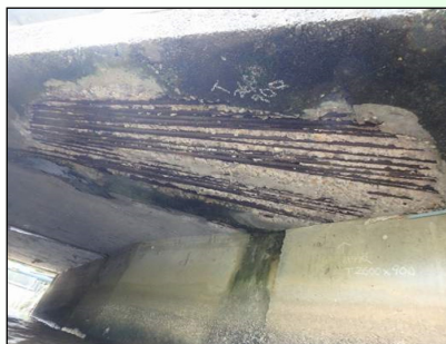
コンクリート橋の床版
