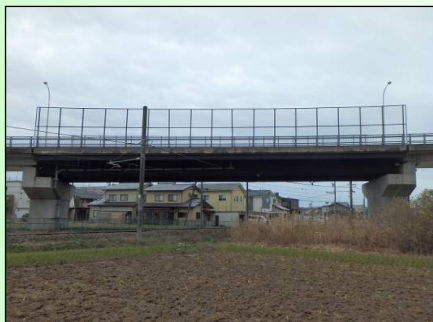
清水跨線橋 橋長 140m 昭和 63 年架設
