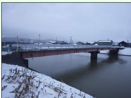
中橋橋 橋長 55.87m 昭和 52 年架設
