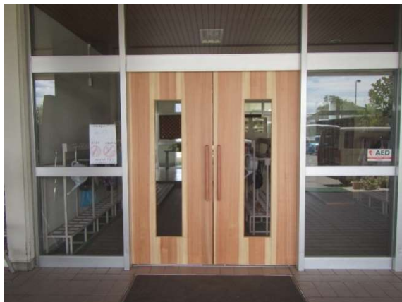
井上小学校 玄関扉
