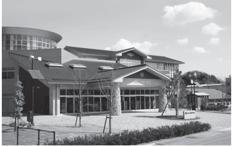
正面右手の大きな太陽光発電パネル (10.6kw) が目を引く。風力発電照明や雨水タンクを備えるほか、校舎自体の高さを抑えることで環境に配慮したものとなった。
