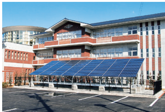
自然エネルギー設備を導入した小学校
