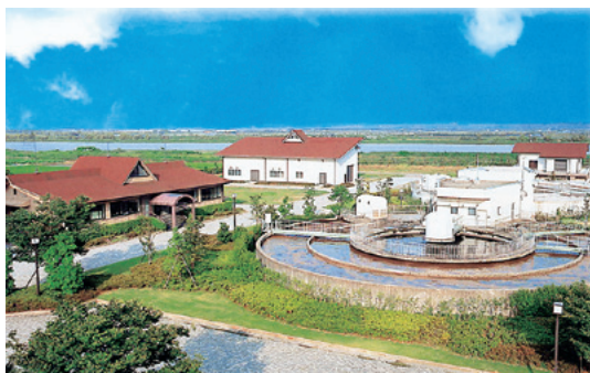
町浄化センター
