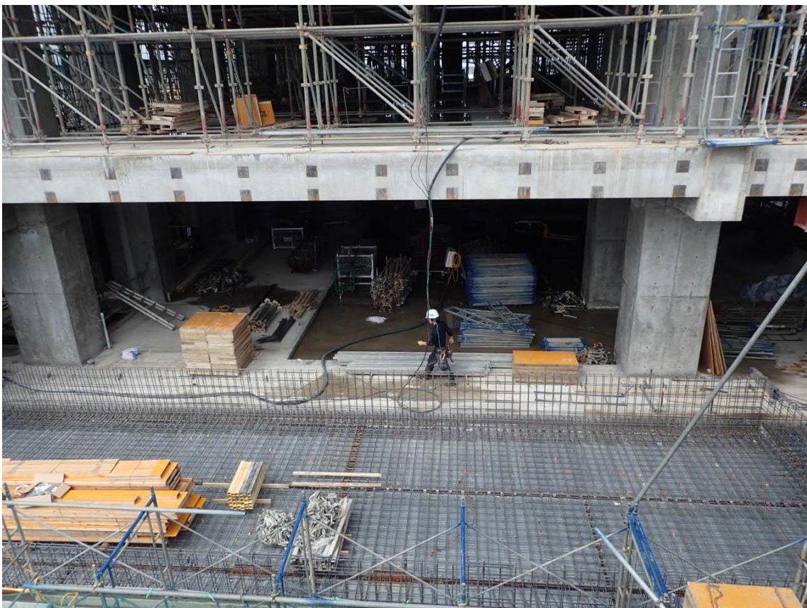
新庁舎内部の作業も同時に進めています。
