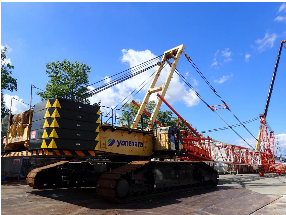
令和2年3月末から稼働した350tクローラークレーンの解体を行っています。
