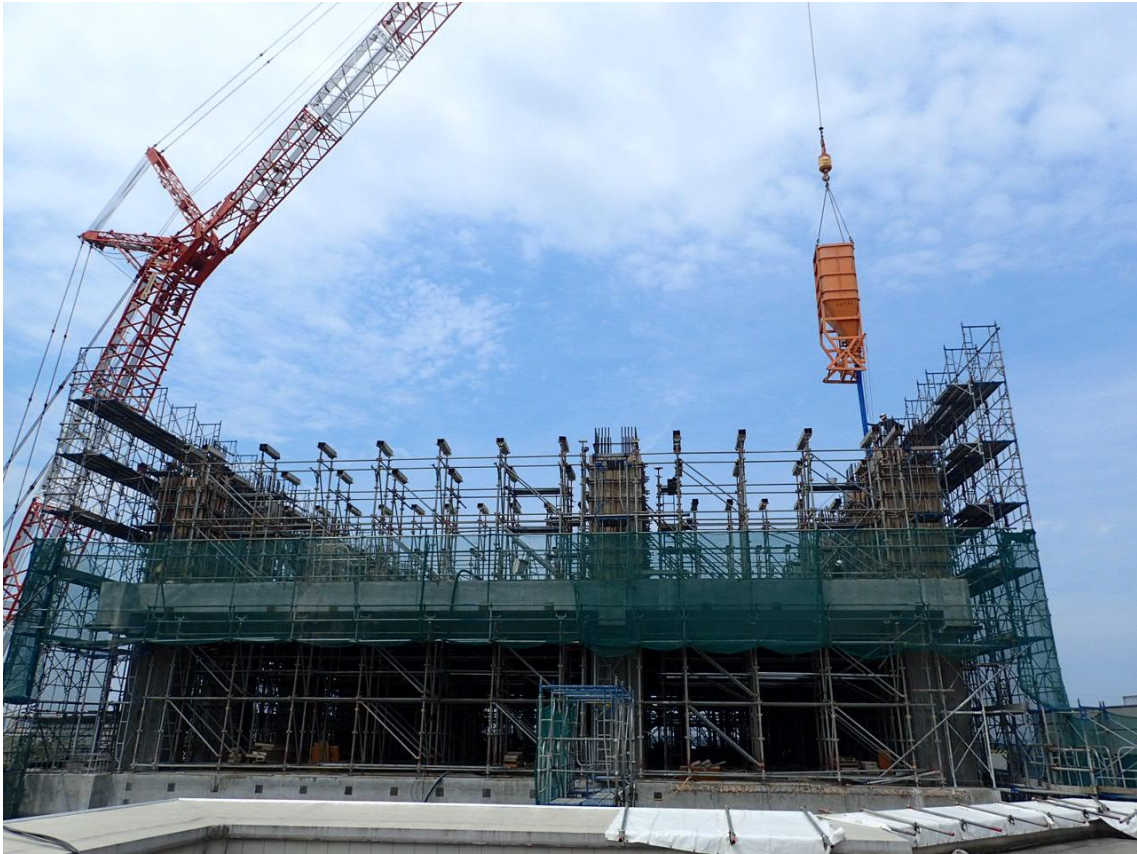
令和2年7月20日 4階柱部分のコンクリート打設を行っています。
