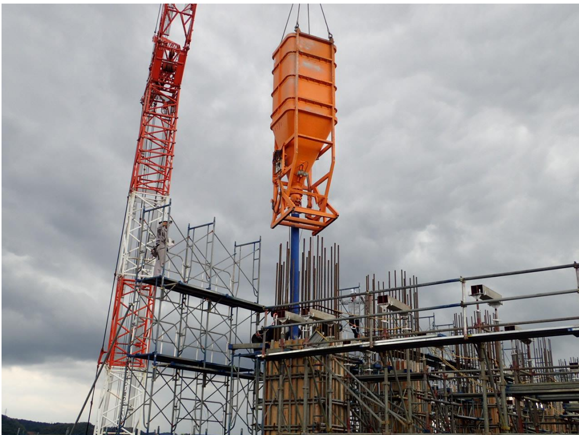
クローラークレーンで生コンクリートの入ったバケットを吊り上げて、型枠に流し込んでいます。
