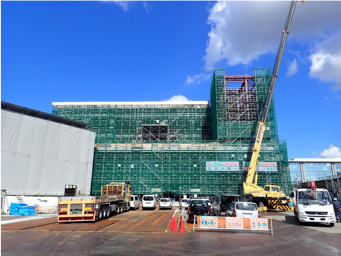
令和2年9月19日 新庁舎1階から4階をつなぐ階段室の鉄骨が組み上がってきました。
