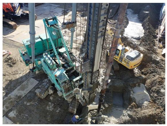
令和元年 11 月 13 日 杭打ち機及びクローラークレーンが搬入され、杭打ち作業を進めています。
