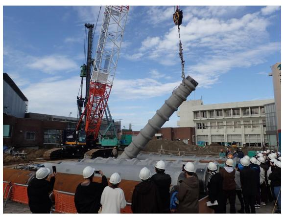
クローラークレーンにて直径1メートルの杭を持ち上げる様子を見学する学生。
