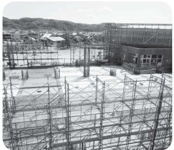
▲着々と進む工事
