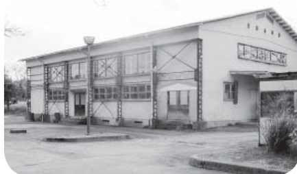
▲解体される笠野屋内ゲートボール場
