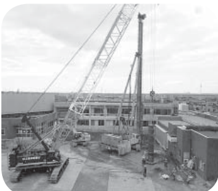
▶新庁舎建設中
