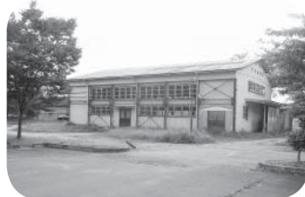
▲老朽化により解体予定
