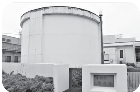
安全な水を安定供給 (町浄水場)
