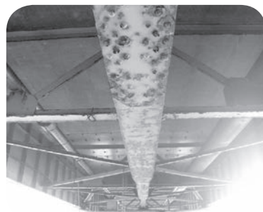
▲さびた橋の裏側も補修
