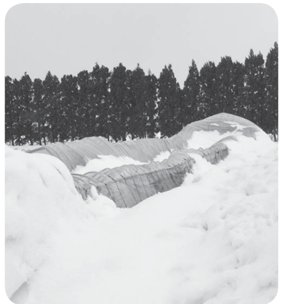
▲大雪で倒壊した農業ハウス
