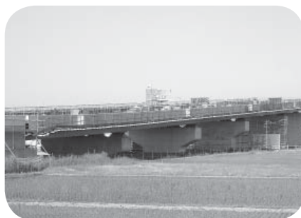
整備される道路 (金沢市)
