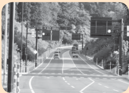
▲完成された河北縦断道路
