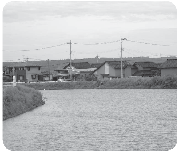
▲整備された津幡川
