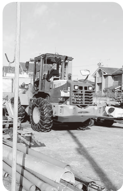
▲建設工事現場
